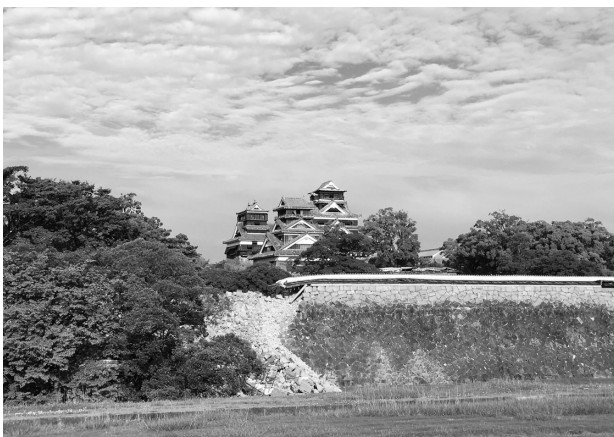
石垣や屋根瓦が崩れた熊本城
